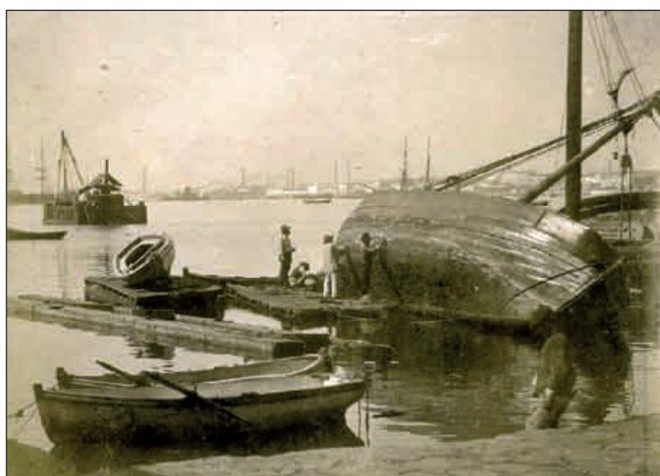
Limpiando la obra viva
